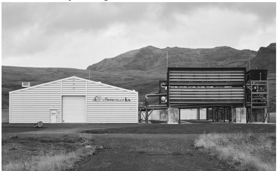
Figure 2 : Centrale géothermique en Islande avec capture du CO 2 . En Islande, Climeworks est la première usine commerciale au monde qui capture le dioxyde de carbone directement dans l'air. C'est une entreprise suisse qui fonctionne à l'énergie géothermique. Elle a une capacité de captage de 4 000 tonnes de CO 2 par an. Le gaz purifié est injecté en profondeur, où il se minéralise avec la roche souterraine. (Crédits : Climeworks )
