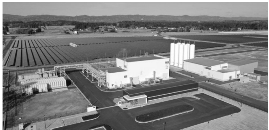
Figure 2 : Le Centre de recherche de l'hydrogène énergétique à Fukushima. C'est la plus grande usine d'hydrogène vert au monde, qui a ouvert ses portes en 2020 et produit 2,4 tonnes par jour. Elle est alimentée par des panneaux solaires installés sur place. (Crédit : Fukushima Hydrogen Energy Research Field)
